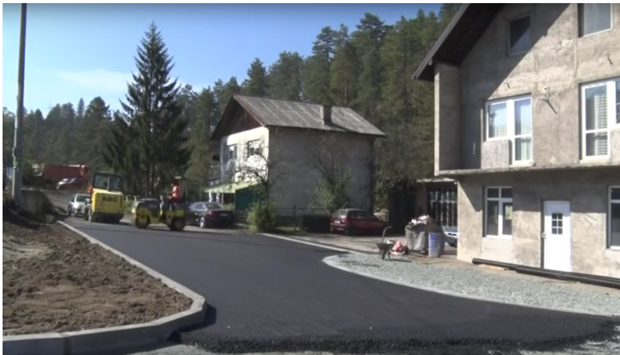
15. Radovi na asfaltiranju puta u MZ Oskova
