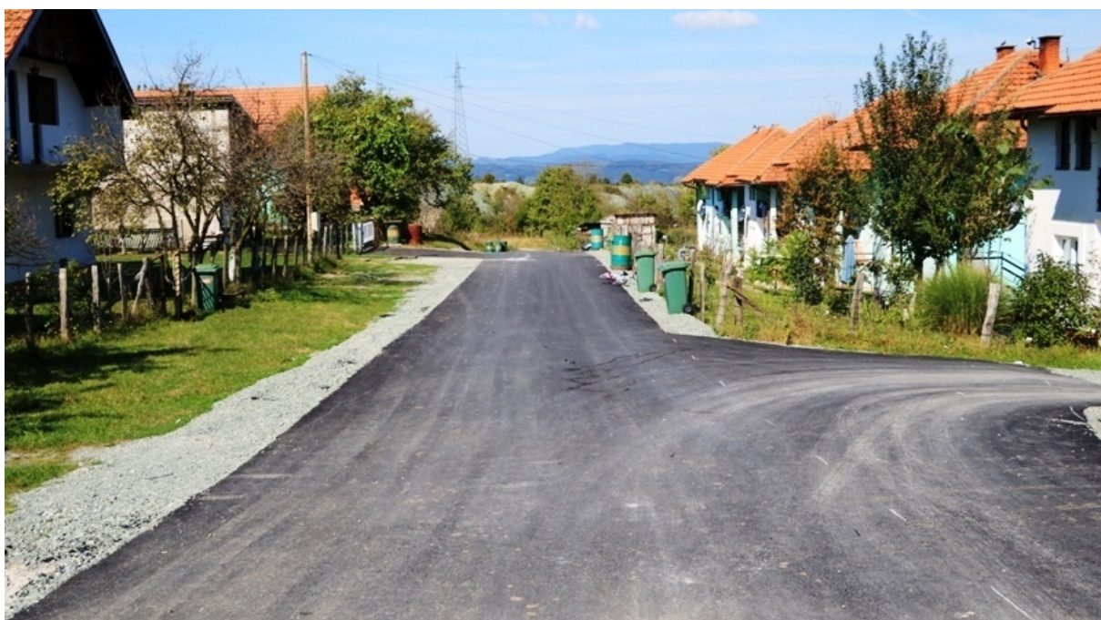
13. i 14. Asfaltiranje mjesnog puta u MZ Stražbenica
