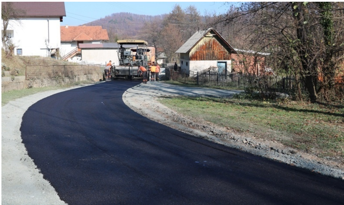
11. Asfaltiranje mjesnog puta u Mrljevićima, MZ Repnik
