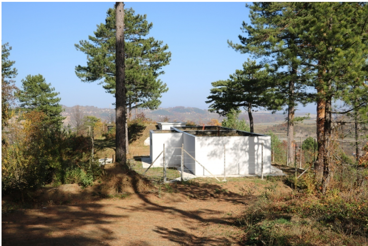
17. Radovi na mjesnom vodovodu u MZ Banovići Selo
