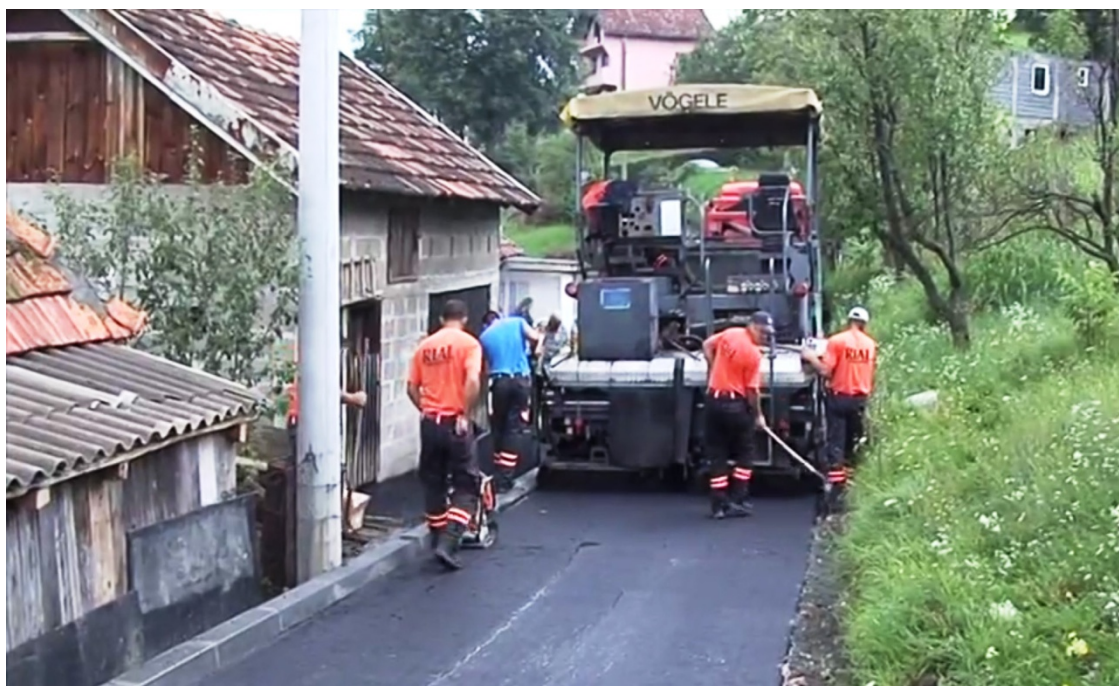
6. Radovi na asfaltiranju mjesnog puta u MZ Tulovići
