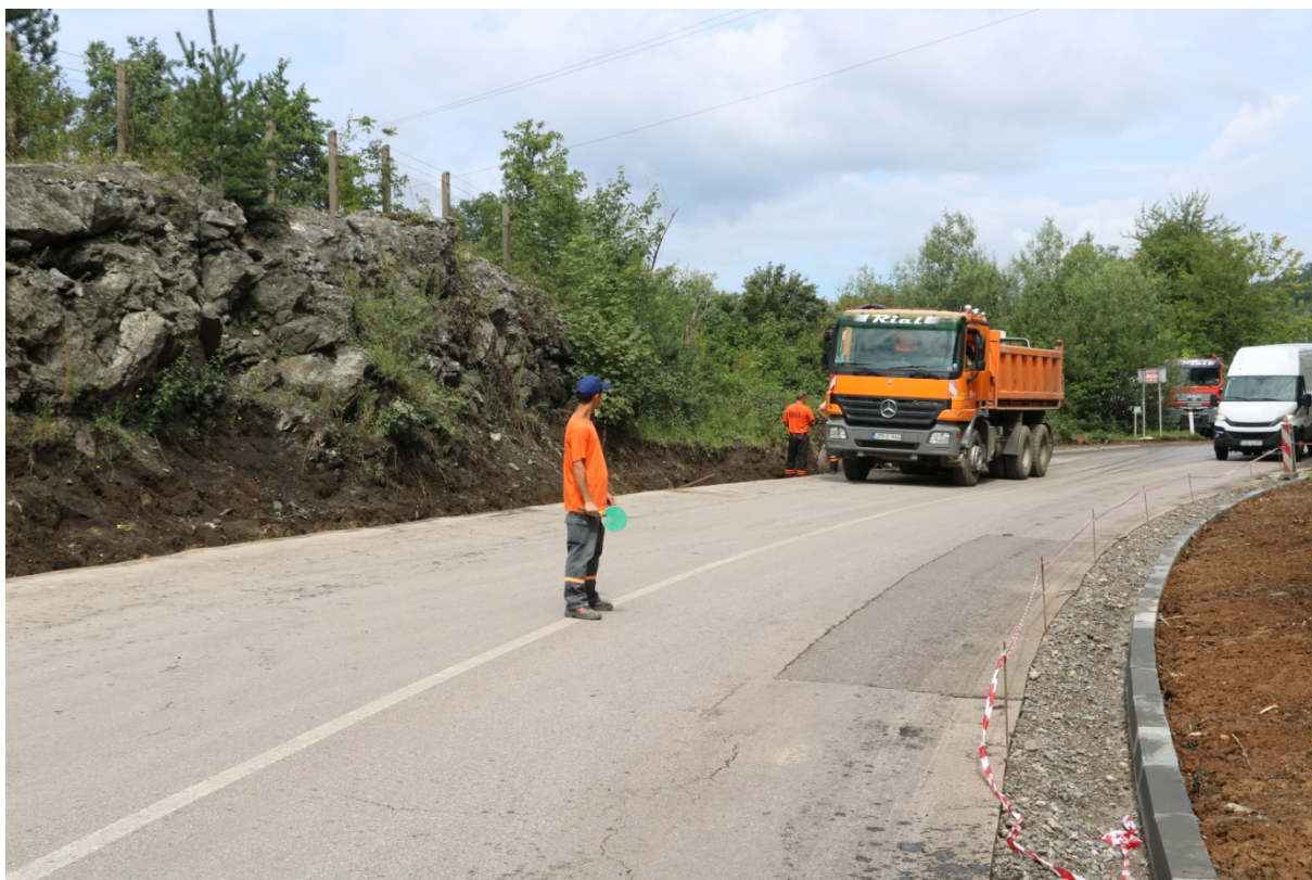
18. Radovi na rekonstrukciji dionice puta Banovići – Živinice
