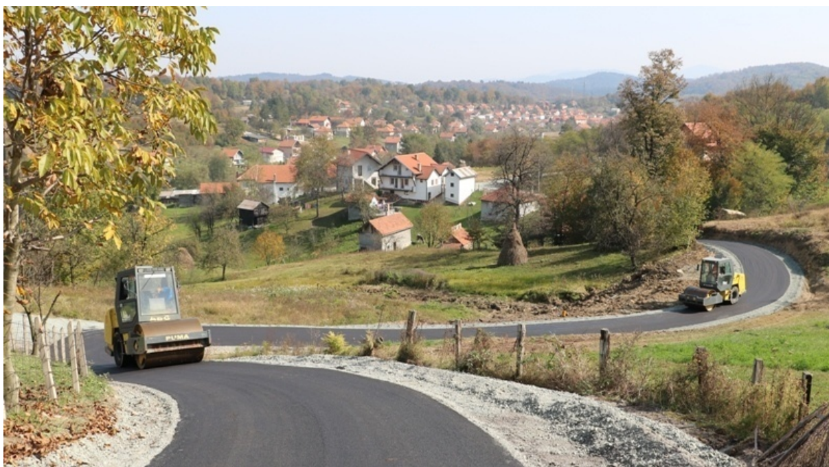
12. Asfaltiranje mjesnog puta u MZ Grivice
