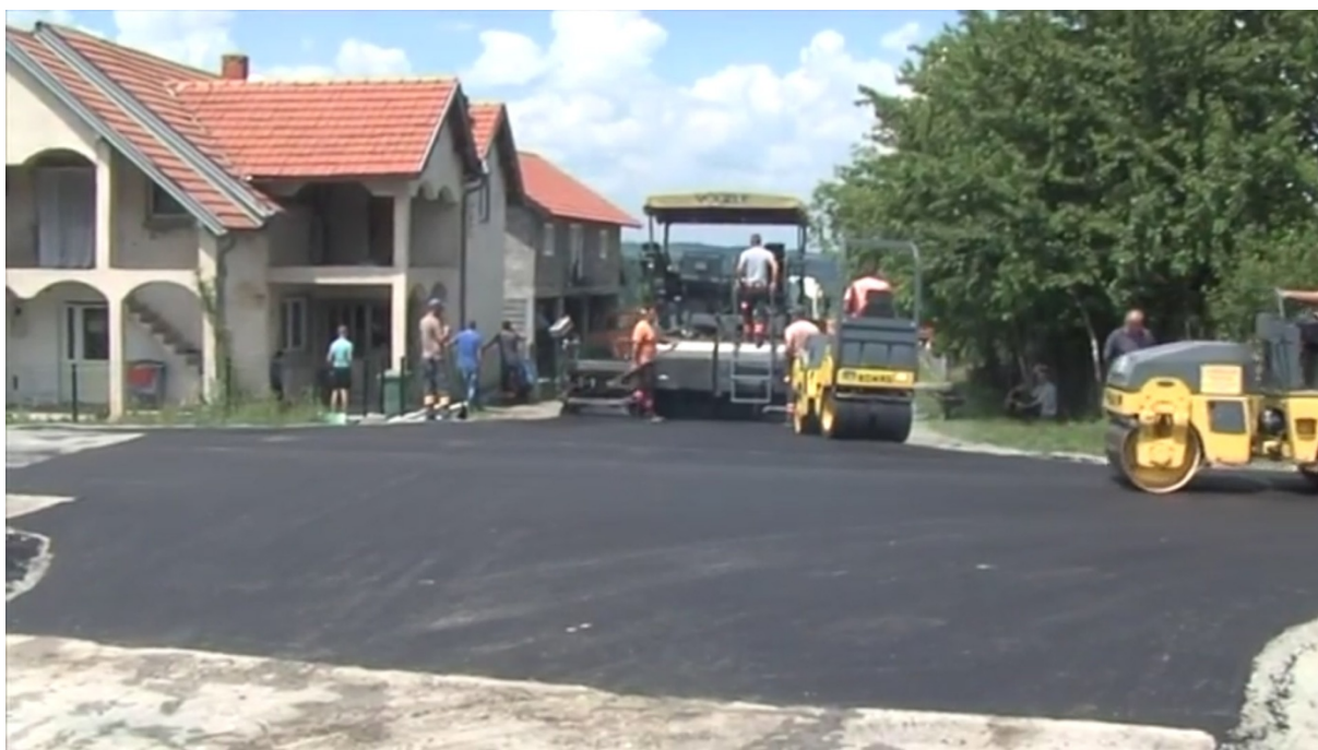
16. Radovi na afaltiranju mjesnog puta u MZ Banovići Selo (Selo 2 i 3)
