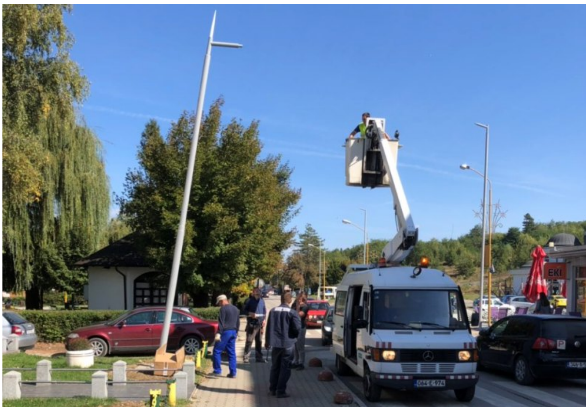
8. Postavljanje LED ulične rasvjete u ulici Alije Izetbegovića
